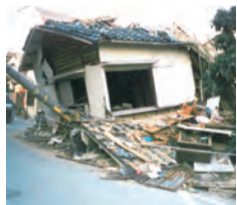
実験と同じ震度7による被害
