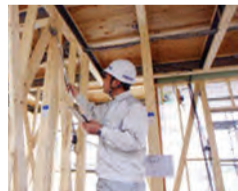
施工管理者等による施工検査
