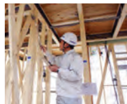
施工管理者等による施工検査
