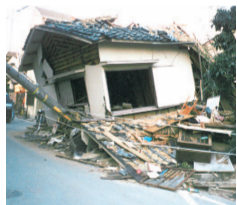
実験と同じ震度7による被害
