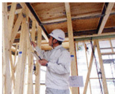
施工管理者等による施工検査
